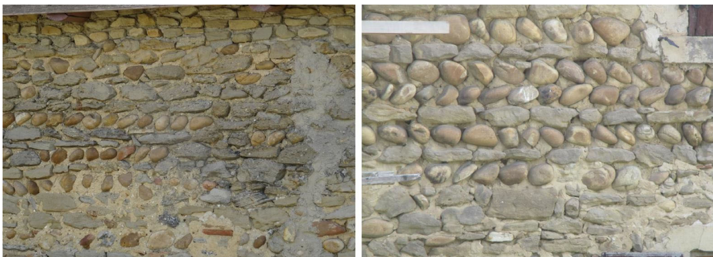
Photographies 46 – Remplissage avec une alternance de galets de rivières et de molasse calcaire (Eco-Stratégie, le 03/08/2017)
